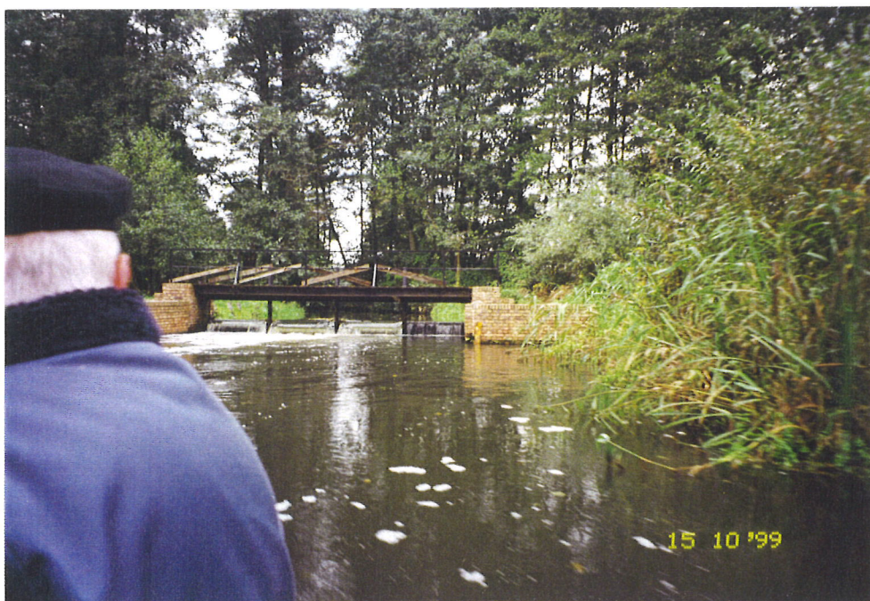
Ansicht vom Unterwasser
